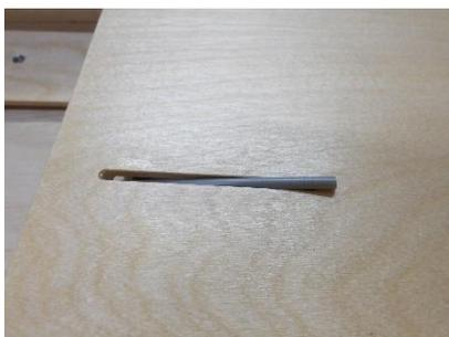
Das Bowdenzugrohr für die Ruderanlenkung wird eingeklebt.
