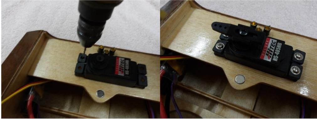
An seinem Platz wird es mit den beiliegenden Schrauben festgeschraubt. Dazu wird mit 1,5 mm vorgebohrt. Nachdem das Servo auf Mitte gestellt ist (Servotester oder RC-Anlage) wird der verstellbare Servoarm befestigt.
